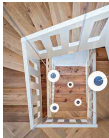
Das alte Treppenhaus wurde revitalisiert, und die Spezialisten von Treppenbau Gritsch fügten im oberen Teil eine neue Faltnesttreppe mit einer weißen Geländerwanne nahtlos ein.
